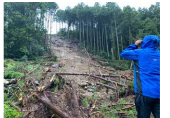
農地の土砂崩れ
